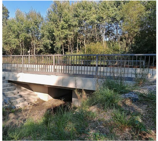
Neues Bauwerk DL km 108,895
