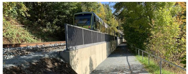
Neue Stützwand, FL 5 - km 19,843-19,936 l.d.B.
