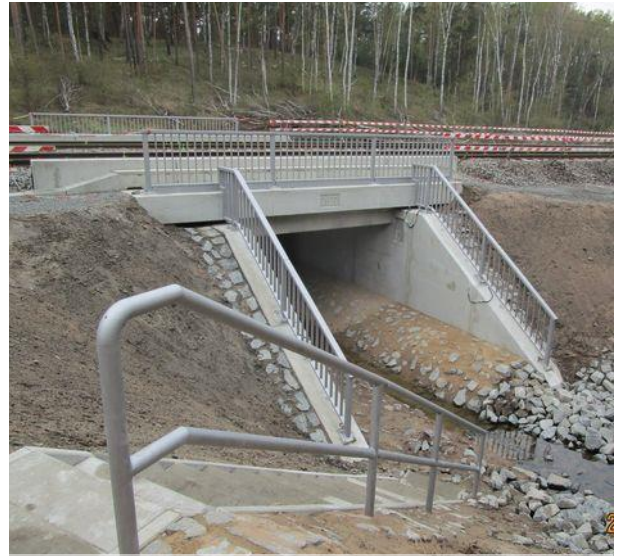
Neues Bauwerk EÜ Mollgraben in Endlage
